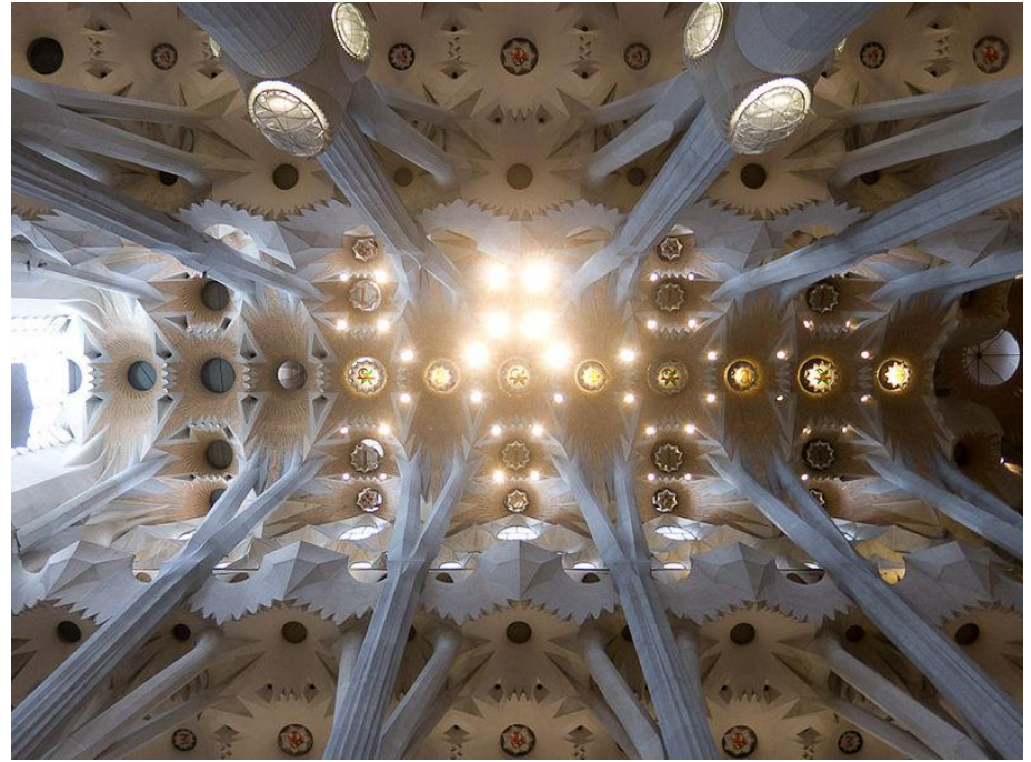
Detalle de la bóveda
